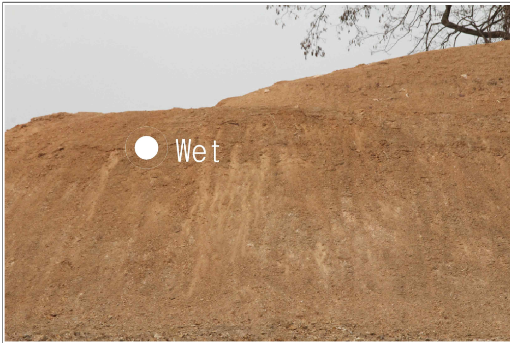
【그림 14】 A 영역 상세사진 (지하수 유출)
