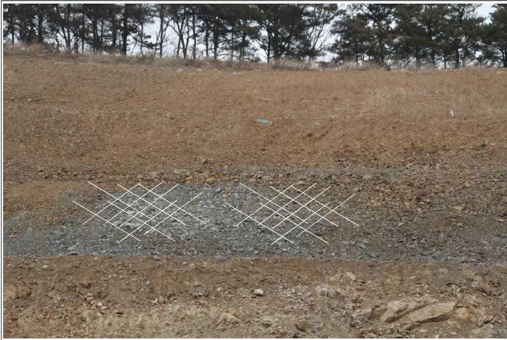
【그림 28】 C 영역 상세사진 (세편화된 암석)
