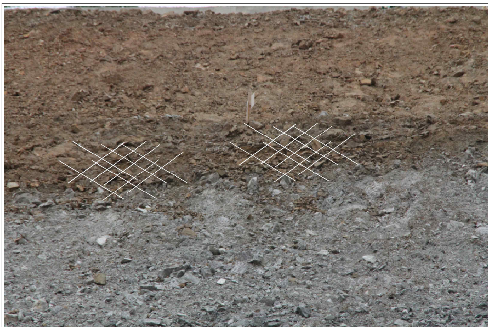
【그림 37】 D 영역 상세사진 (세편화된 암석)
