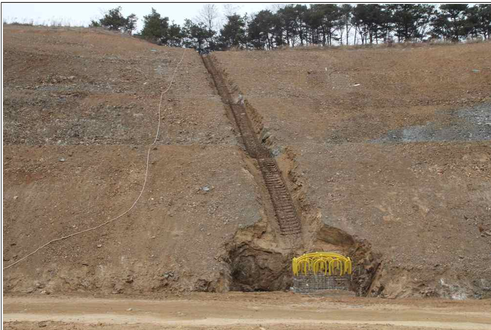
【그림 8】 종배수구 설치 구간
