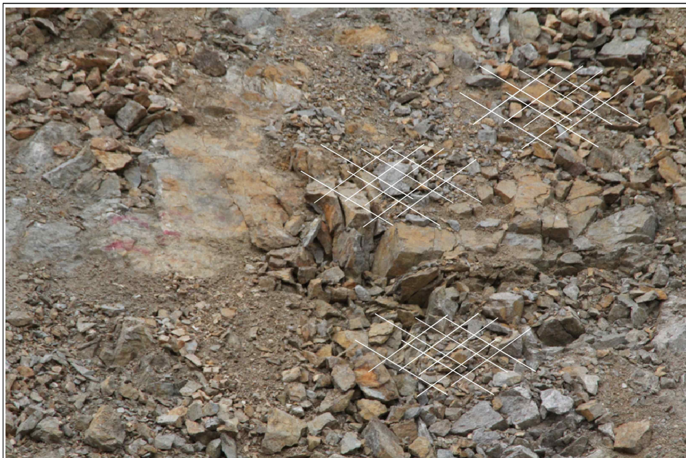
【그림 27】 C 영역 상세사진 (세편화된 암석)
