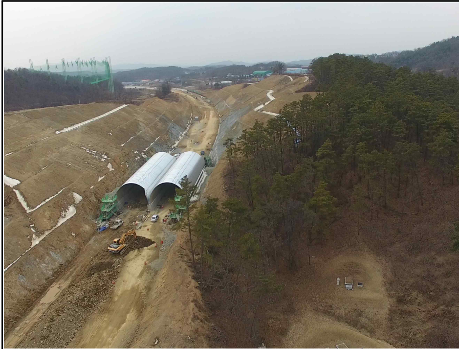
【그림 3】 깎기비탈면 시점부 측면 사진
