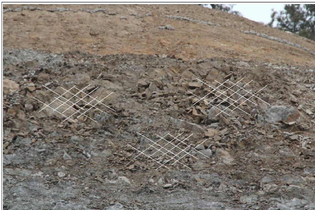
【그림 48】 E 영역 상세사진 (세편화된 암석)
