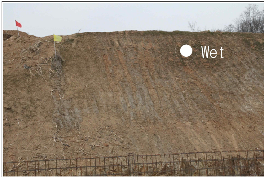
【그림 12】 A 영역 상세사진 (지하수 유출)
