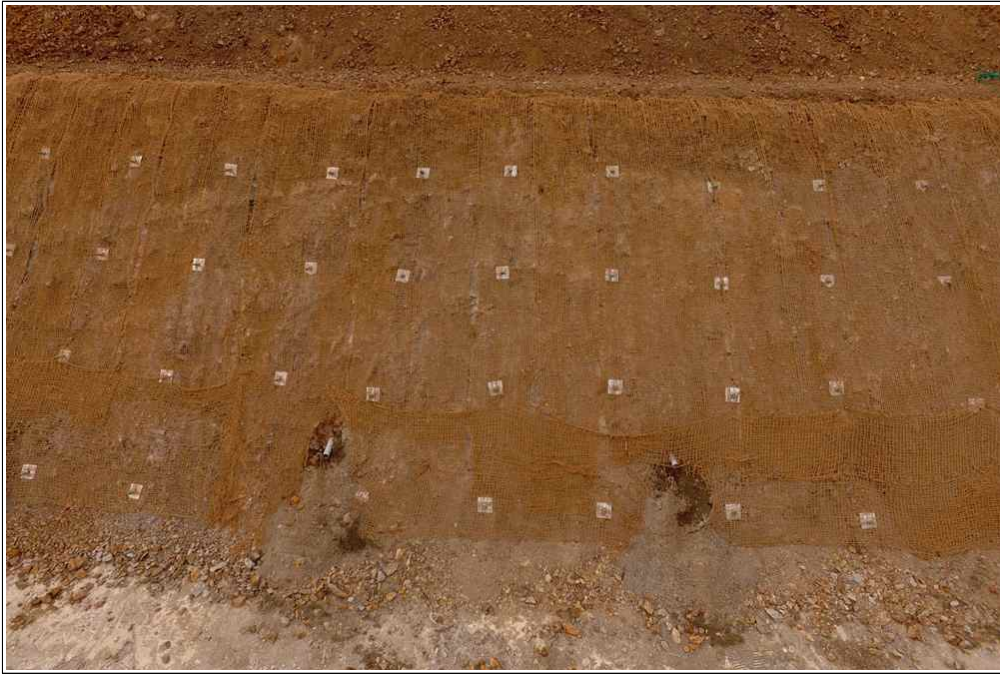
【그림 7】 SoilNail 설치 구간
