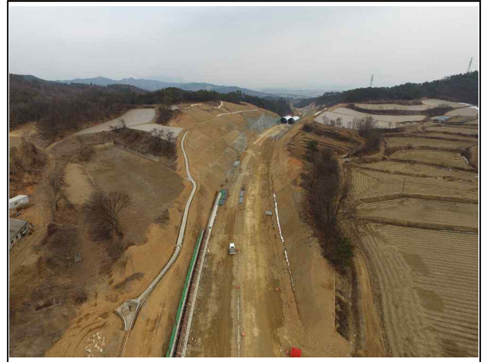
【그림 4】 깎기비탈면 종점부 측면 사진
