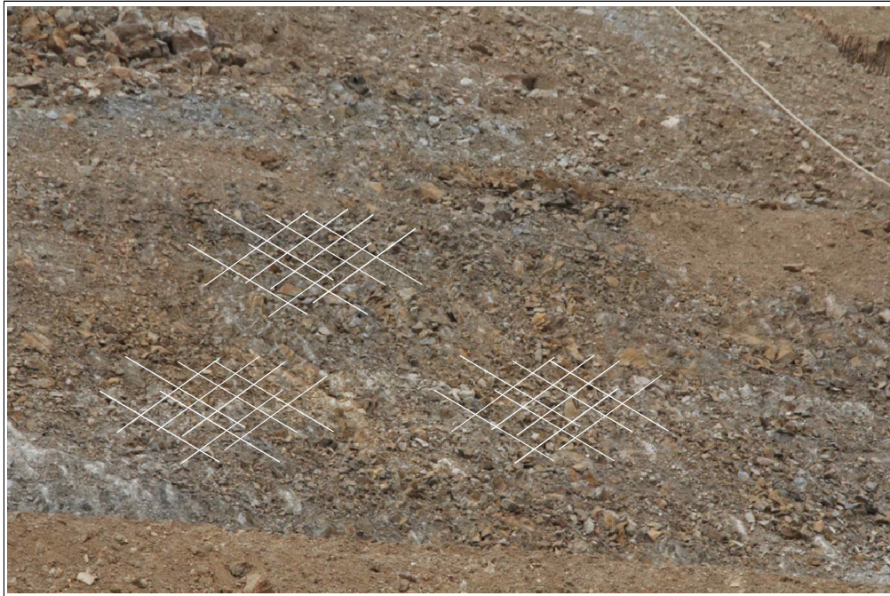
【그림 21】 B 영역 상세사진 (세편화된 암석)
