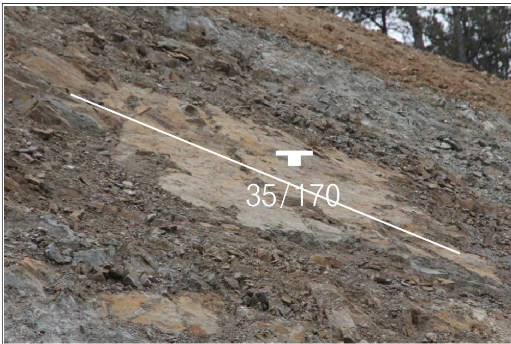
【그림 38】 E 영역에 발달한 불연속면
